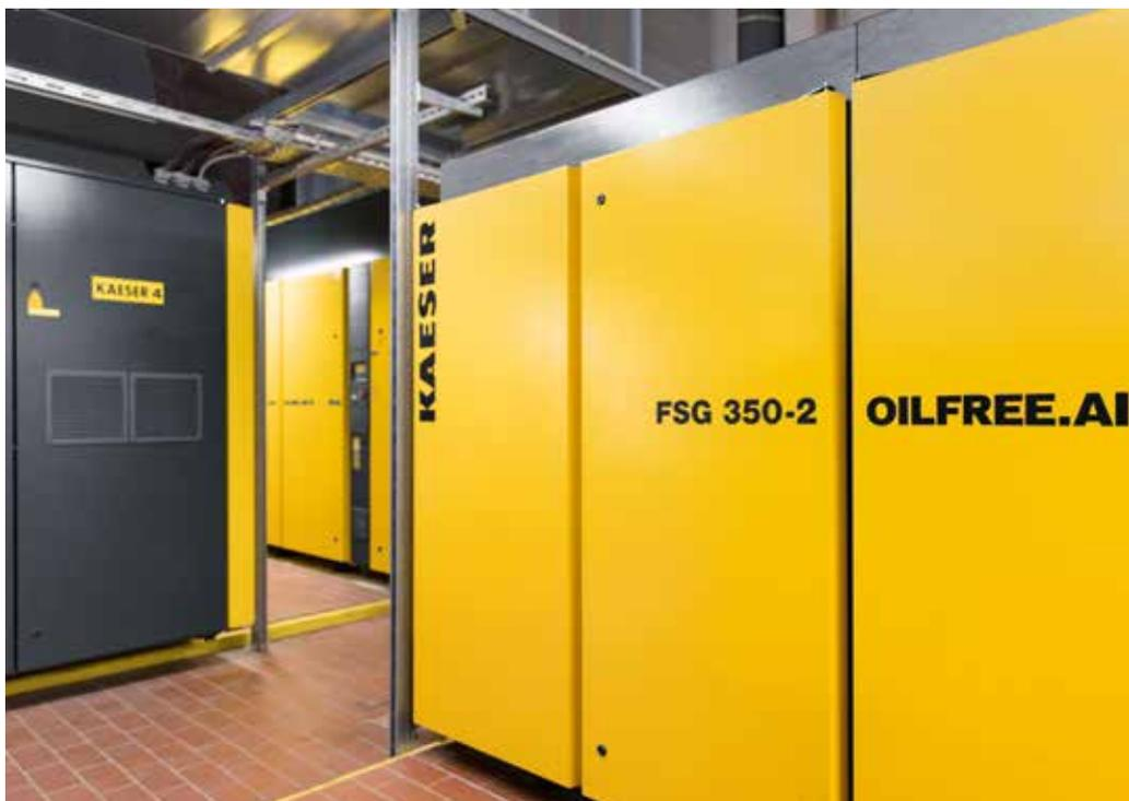
*Dans l'usine de Hanovre, l'air comprimé remplit des fonctions importantes, comme le transport de l'oxyde de plomb.*
