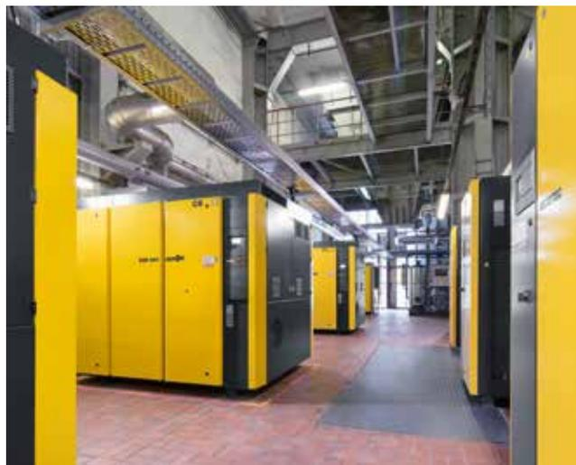
**La station d'air comprimé compte au total quatre compresseurs à vis dotés du PROFIL SIGMA et de moteurs IE4.**
