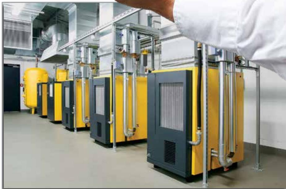
Compresseurs à vis refroidis à l'air, à injection de fluide, dotés d'échangeurs de chaleur internes et de commandes permettant d'exploiter l'énergie thermique du fluide de refroidissement. Les conduits supplémentaires évacuent l'air chaud qui n'a pas été rejeté par le système de récupération à eau chaude.
